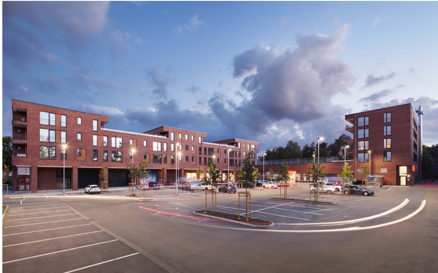
Cuxhavener Strasse, Hamburg 2018, IBA Eingangsquartier Fischbeker Heidbrook, Wohnen über Nahversorger LRW Architekten und Stadtplaner, Foto: Piet Niemann
