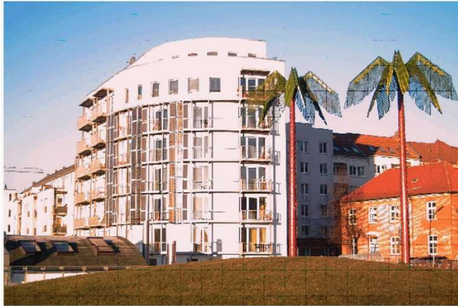
Passivhaus Pinnasberg der Genossenschaft St. Pauli Hafenstrasse, 2004
