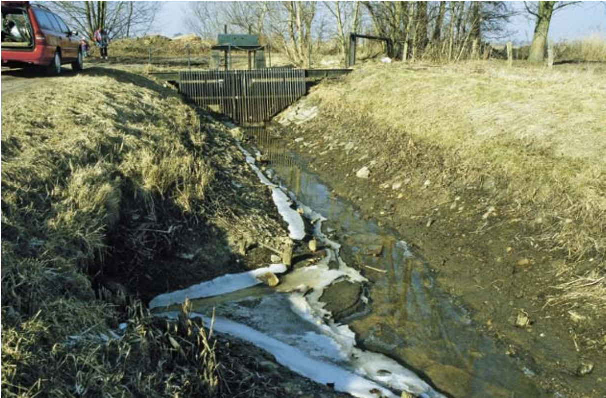
Abbildung 30. Wasserabsenkung im Neuengammer Sammelgraben.
