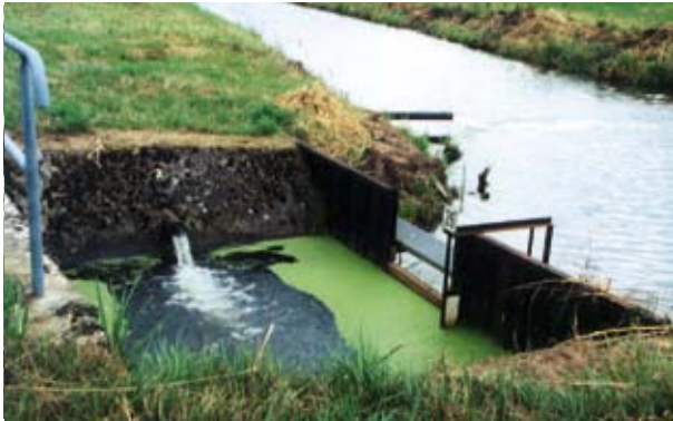
Abbildung 18. Pumpensumpf, Fassungsräben Curslack.
